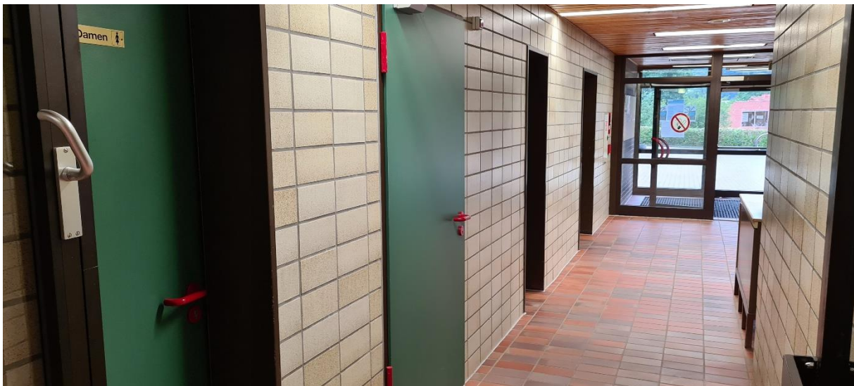
Sicht vom Ende langen Flur zum öffentlichen Bereich auf WC-Anlagen, Tür Cafeteria-Verkauf und Eingangsbereich der Sporthalle, rechte Seite kleine Theke für zweite kleinere Hygienestation
